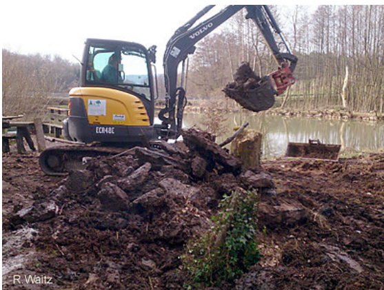
Bagger beim Zerkleinern einer Betonplatte (Foto: R. Waitz).
