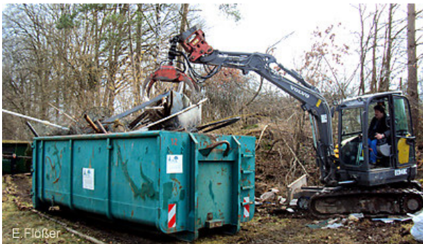
Insgesamt 9 Container Metallschrott, Altholz und Bauschutt wurden entfernt (Foto: E. Flößer)
