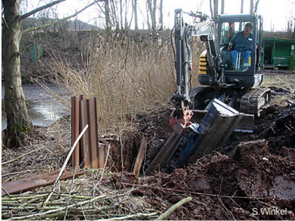
Entfernung von schweren Eisenplatten und Verschalungen (Foto: S. Winkel).
