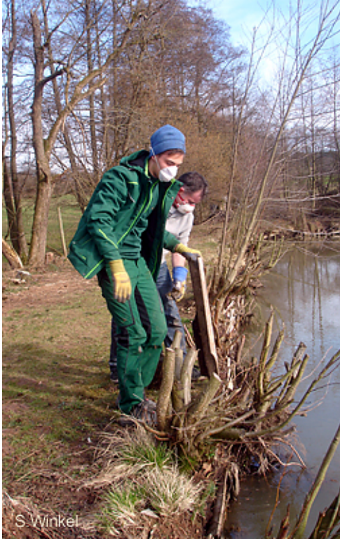
Beim Abbau von Asbestverbauungen sind Handschuhe und Mundschutz Pflicht (Foto: S. Winkel).
