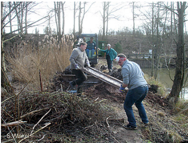
Trotz Baggereinsatz ist auch Handarbeit gefordert (Foto: S. Winkel).
